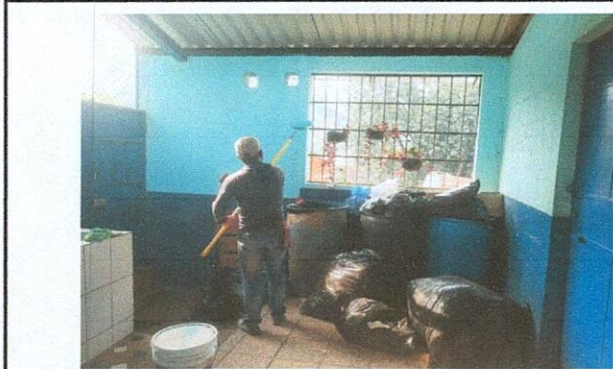
Foto1: Aplicación de pintura interiores
