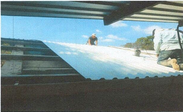
Foto 9: Cambio de techo dañado
