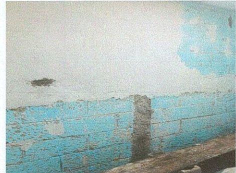
Foto 10: Reforzamiento de capas de cemento para cubrir agujeros.
